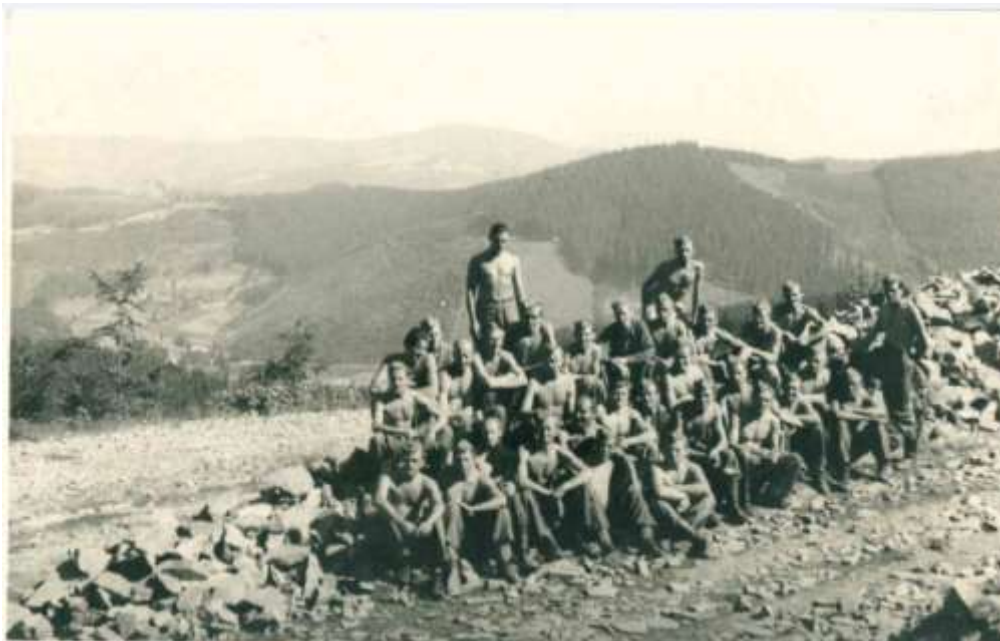
Brigáda při stavbě silnice do Makova
