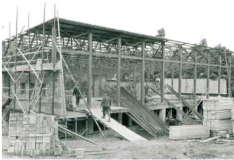
Stavba Kulturního domu v Podhradní Lhotě
